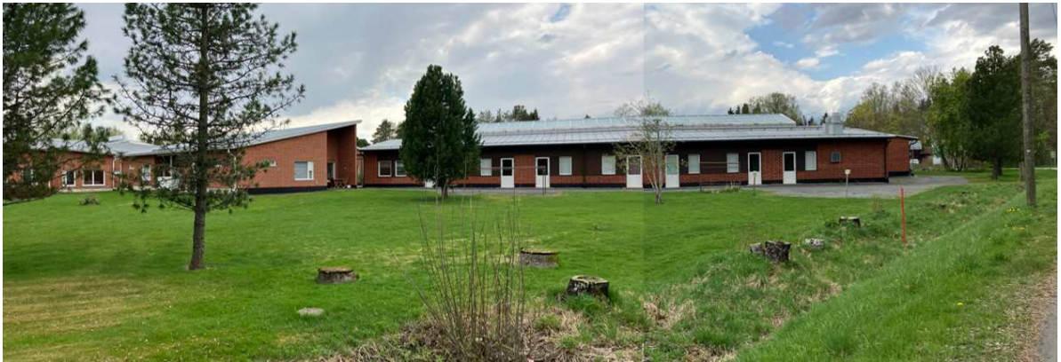
Kuva 13. Länsitien suunnasta alueen rakennuskantaa (Ramboll Finland Oy 05/2026).
